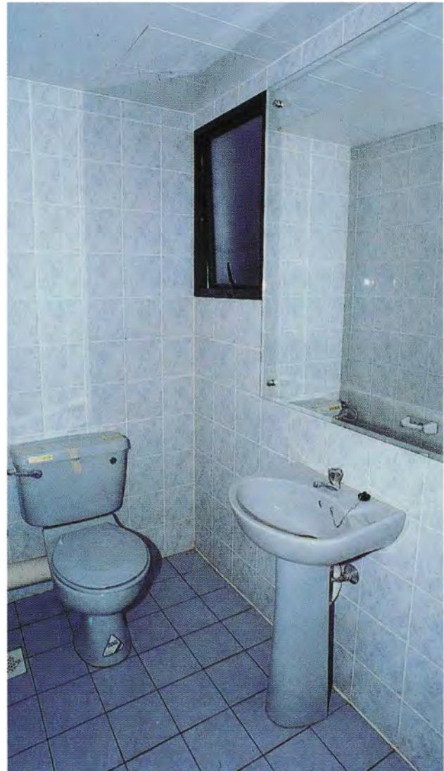
Precast toilet unit
