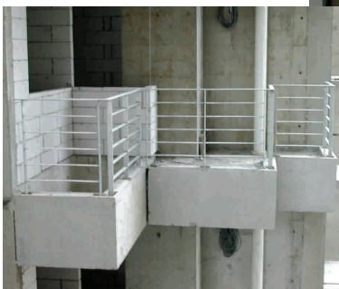
Fig. 6.7 – Precast air con ledges
